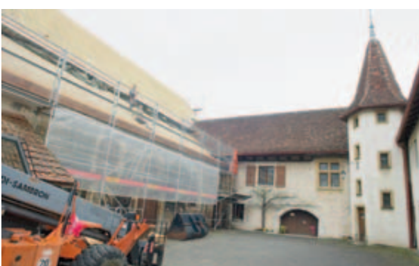
Les 220 000 tuiles du prieuré sont changées. DAVID MARCHON
