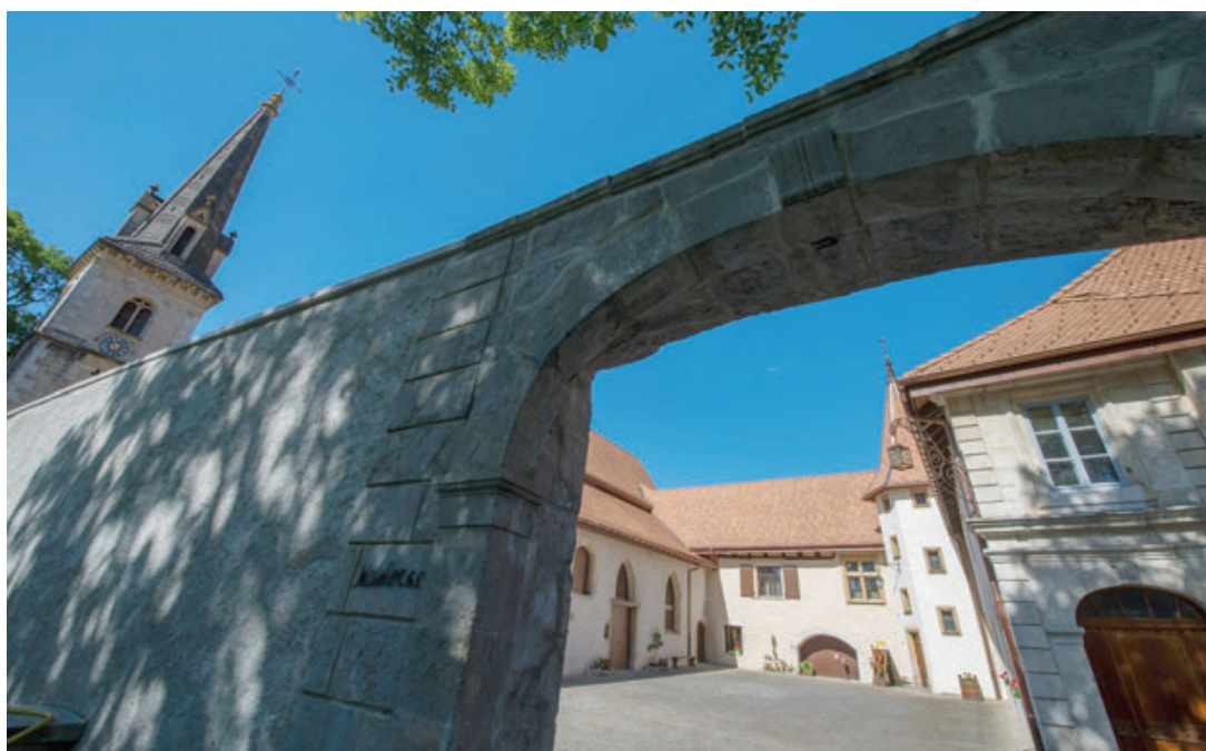
Le mur d'entrée a été rénové et un appentis, sans valeur historique et donnant sur la cour, a été supprimé.
